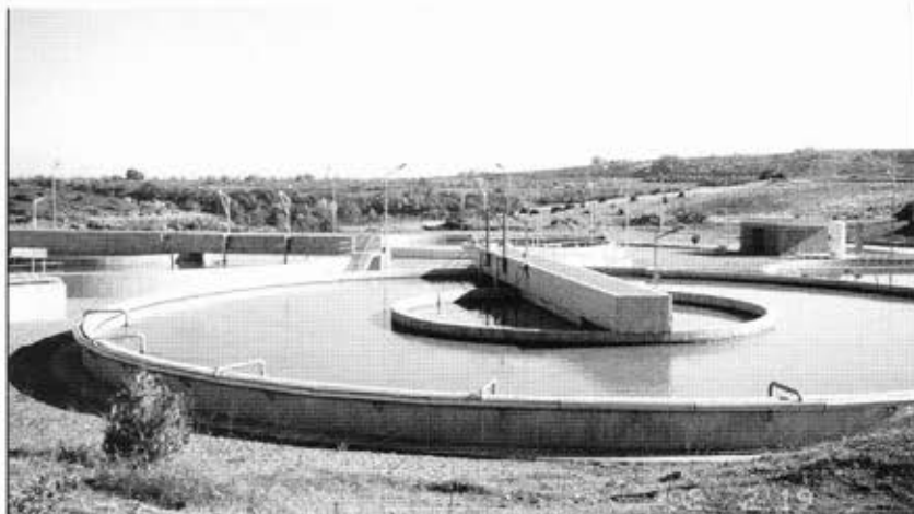
Οι εγκαταστάσεις του Βιολογικού Σταθμού Νάουσας
