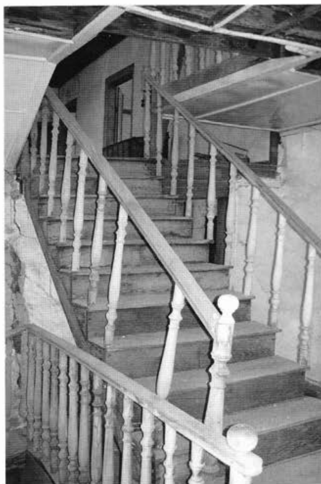
Η ξύλινη σκάλα για τον Β' όροφο
