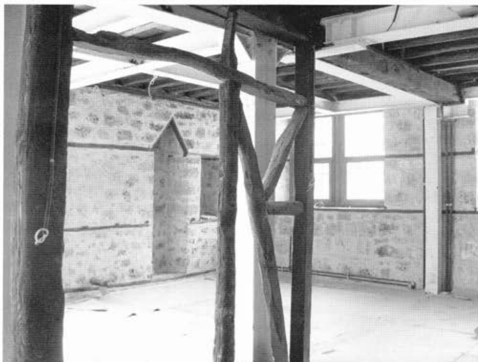
Το σύστημα ενίσχυσης των φορέων με σιδηροζατασκευή
