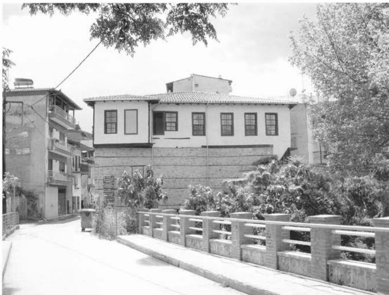
Η βόρεια όψη από τη γέφυρα «μπατάνια»
