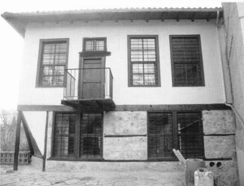
Η πίσω όψη πριν και μετά την αποκατάσταση
