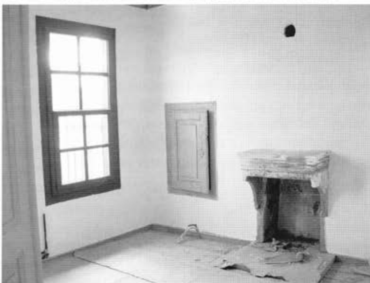
Τμήμα τοίχου με τζάκι κατά τις εργασίες ενίσχυσης και μετά την αποκατάσταση
