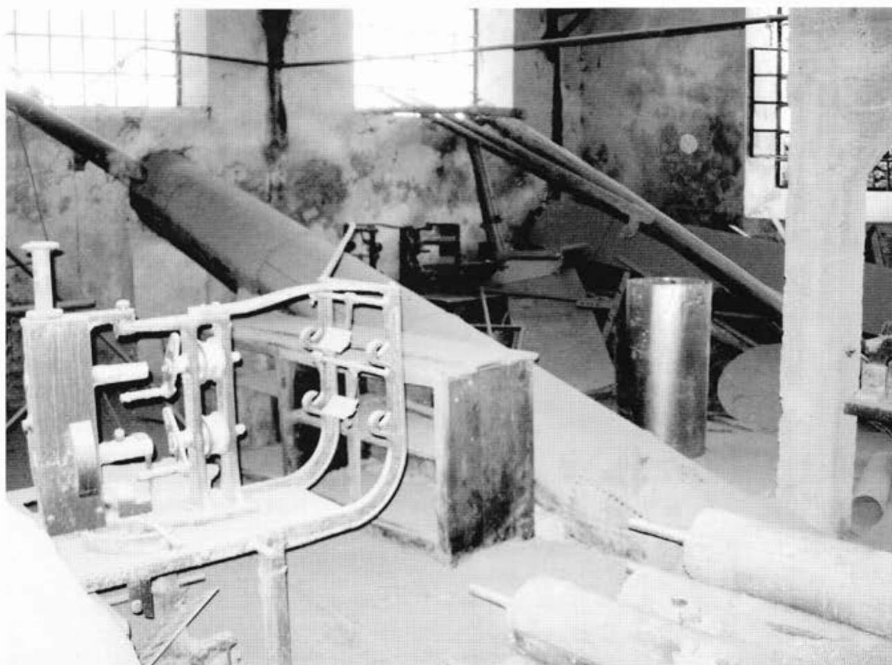
Ο κεντρικός προσαγωγός σωλήνας που οδηγεί το νερό στην τουρμπίνα
