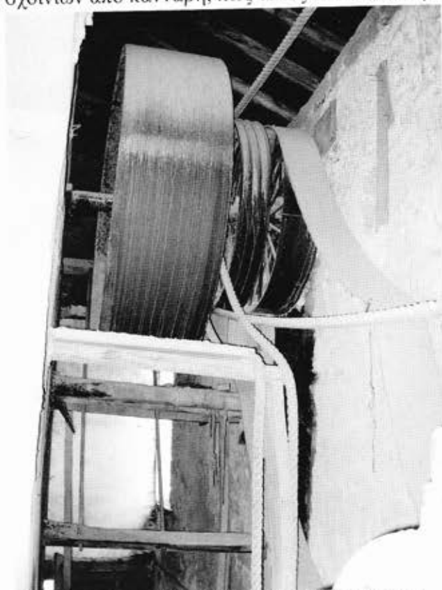
Η βασική τροχάλια που μεταδίδει την κίνηση στον κεντρικό άξονα του εργοστασίου
