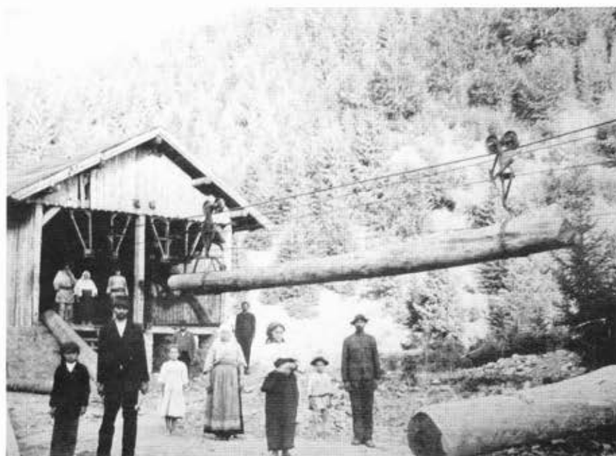
Μονάδα κοπής και κατεργασίας ξυλείας στο Βέρμιο (περιοχή Γουρνόσοβο) Η ξυλεία μεταφερόταν με εναέριο σύστημα μέχρι τα Λευκάδια
