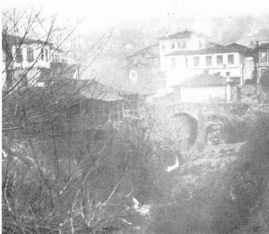
Η γέφυρα στα «Μπατάνια»
