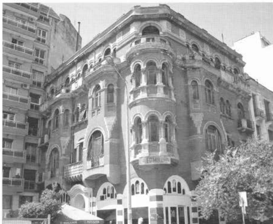
Το «μέγαρο Λόγγου» χτισμένο στη συμβολή των οδών Αγίας Σοφίας και Ερμού, απέναντι από τον Ναό Αγίας Σοφίας, κτίριο κόσμημα της Θεσσαλονίκης
