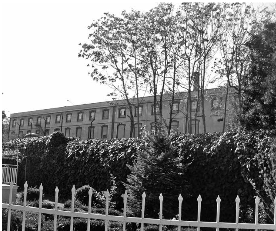
Άποψη των εξωτερικών κτιριακών εγκαταστάσεων του εργοστασίου.
