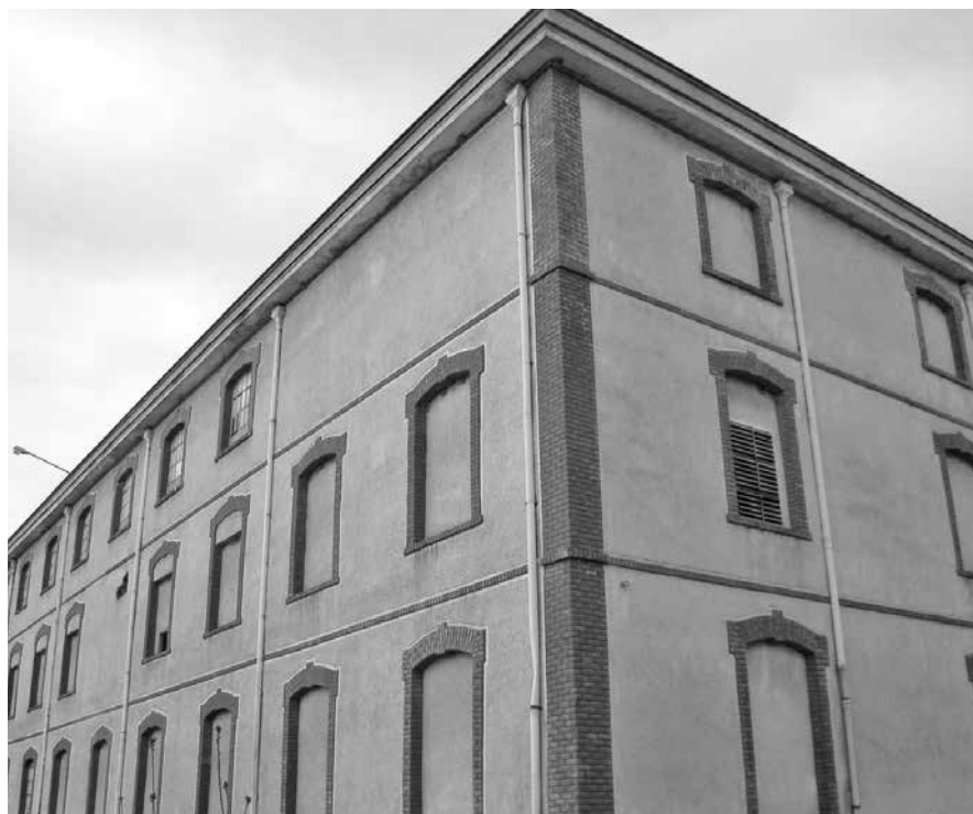
Άποψη του κεντρικού κτιρίου του εργοστασίου Νάουσας «ΛΑΝΑΡΑΣ - ΚΥΡΤΣΗΣ & ΣΙΑ Α.Ε.»
