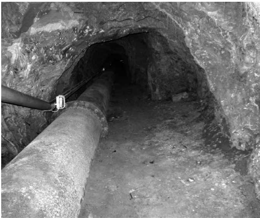
Τούνελ με τον αγωγό νερού (υδατόπτωση) που κινούσε την ηλεκτρογεννήτρια της μονάδας.
