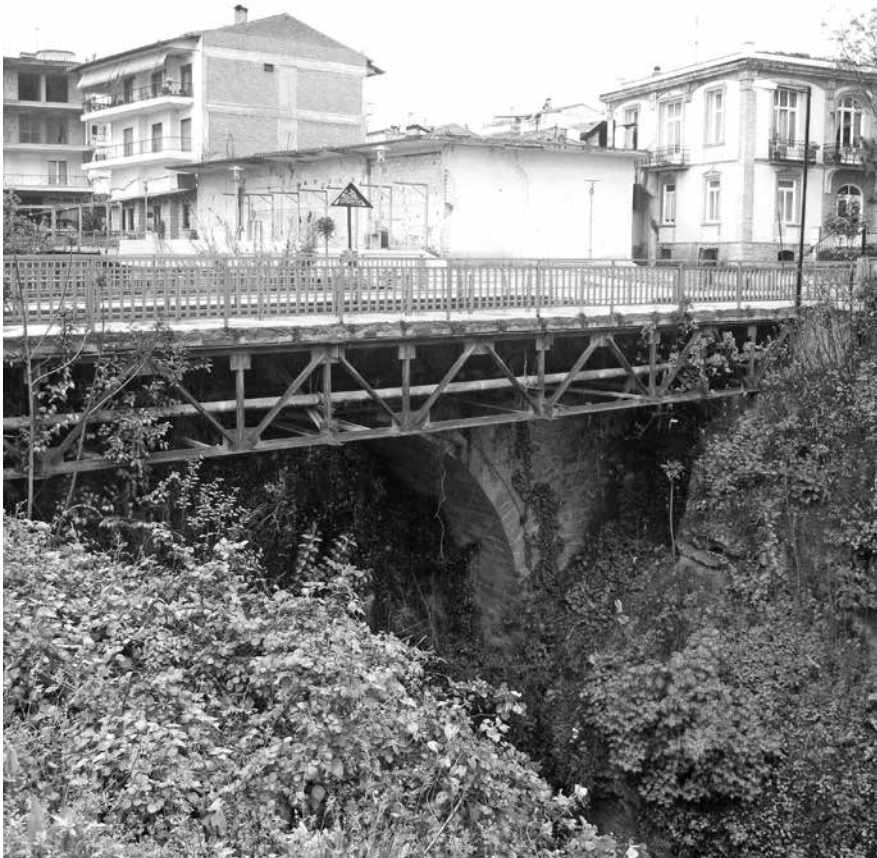
Τα χαλύβδινα ζευκτά όπως τοποθετήθηκαν στη γέφυρα του Νοσοκομείου με σκοπό τη μελλοντική απομάκρυνσή τους όταν κατασκευαστεί η νέα γέφυρα και αναδειχθεί η υπάρχουσα τοξωτή
