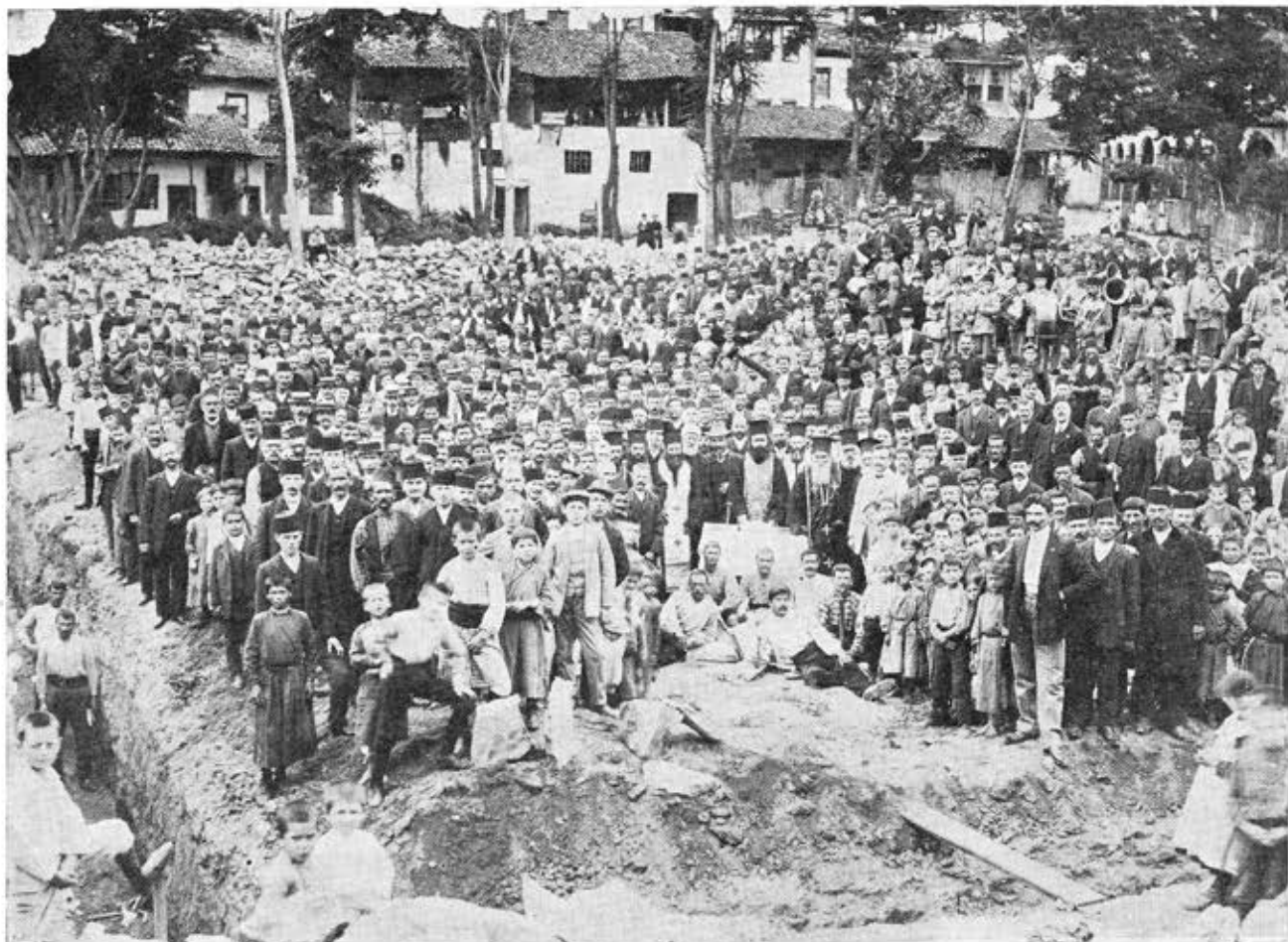
Θεμελίωση του σχολείου του Ἁγίου Μηνά (1911)
