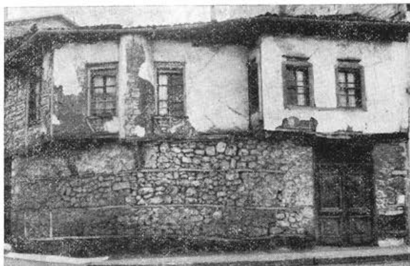
Εξωτερική άποψη του σπιτιού με το χαρακτηριστικό τριγωνικό τζακι και τους τσατμάδες.
