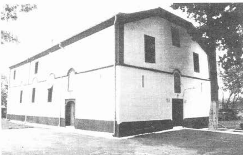
Βόρεια και δυτική όψη του ναού
